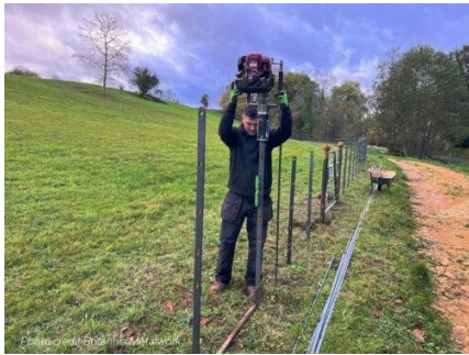
Iberfence IBF-107 în timpul montării unui stâlp.. Fotografie din documentația producătorului.
